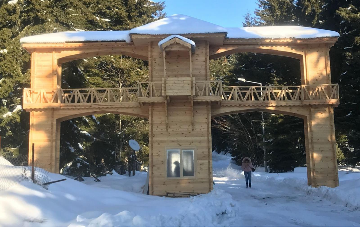
Fotoğraf 3: Şavşat Karagöl MP Giriş Kontrol Ünitesi /ARTVİN
